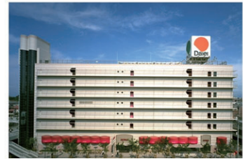
図：旧ジョルノビル
