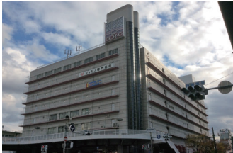
図：解体前の外観写真
